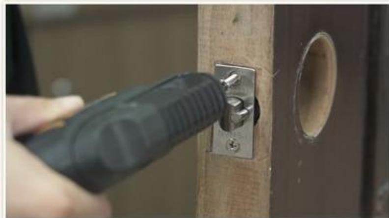
最後以十字螺絲批鬆開鎖舌上下兩粒螺絲，移除原本緊貼的鐵片
